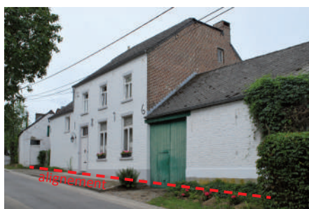
Ancienne ferme implantée avec un très faible recul sur l'alignement.
