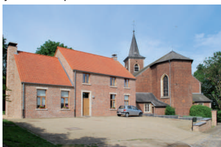
Une légère pente avec petit muret de soutènement
