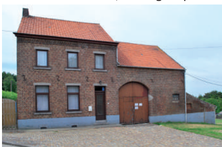
Un accès de plain-pied avec la voirie.
